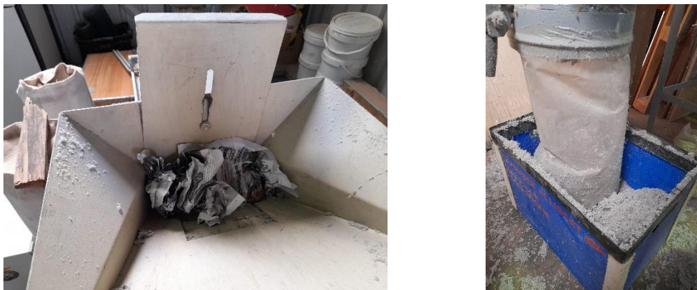
Figura 1. Detalle fabricación aislante de celulosa mediante un molino de martillos en AIDIMME
